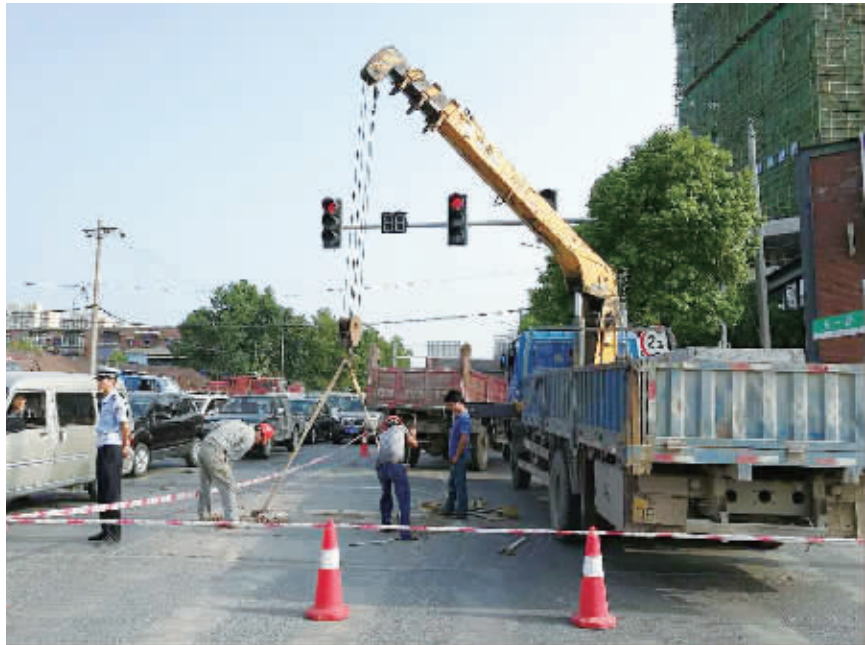
昨日,掇刀区市政园林管理处组织人力物力,对城区五一北路破损的输油管道盖板进行维修,确保周边居民和过往车辆安全出行。 荆门晚报通讯员 王丹丹 摄
